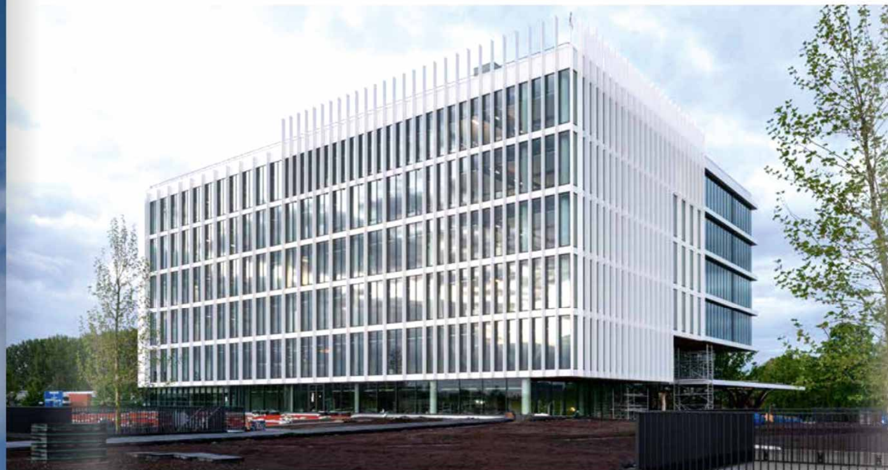
Het markante karakter van het gebouw wordt voor een groot deel bepaald door een uit glas bestaande vliesgevel met daarbij horizontale en verticale belijningen.
