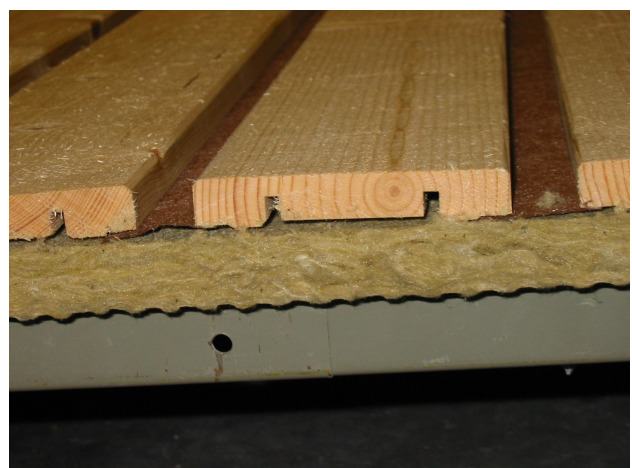
3: detail variante 2 (avec laine de roche)
